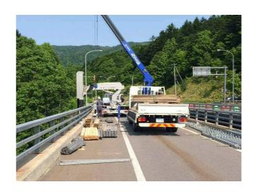
② 在来工法による吊足場架設
