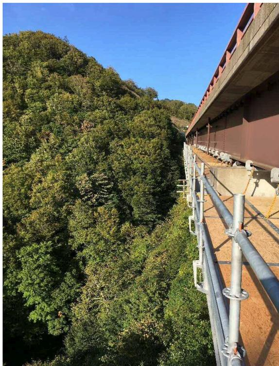
※桁下の作業床が広く確保できています(チェーン間隔2500mm)
